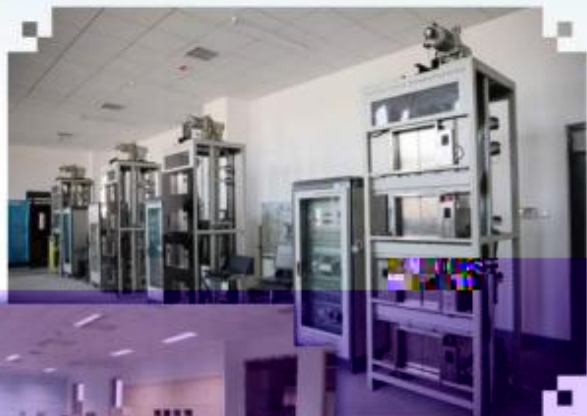
智能电梯安装调试 维护训练场所
